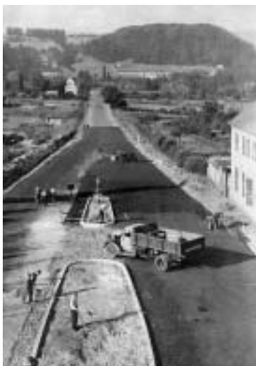
Bauarbeiten auf der Metzger Straße, wahrscheinlich Sommer 1947
